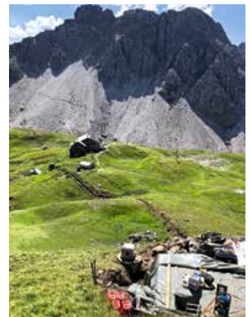
Links: Zwei Tage war der Bagger unterwegs, um zur Baustelle an der Fiderepasshütte zu kommen. Rechts: Die Leitung zwischen Hochbehälter und Hütte musste mit schwerem Gerät gegraben werden.
