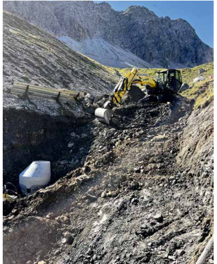
Baumaßnahmen für die Wasserversorgung – wie hier an der Fiderepasshütte – sind aufwändig.
